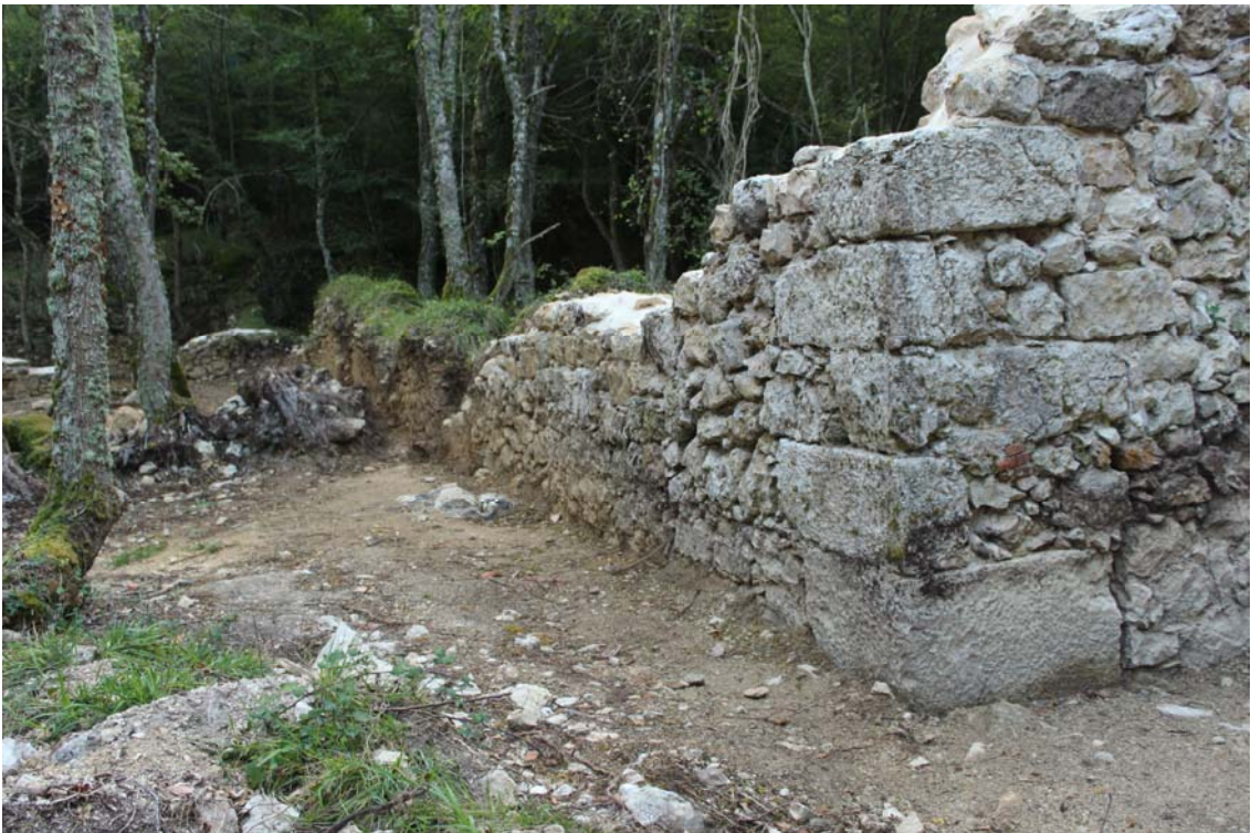
Foto 9. Vista general tras la intervención.
