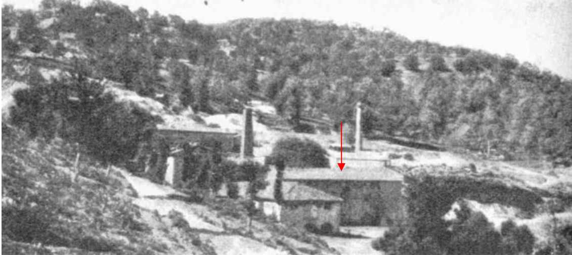
Foto 7. Señalamos el edificio 2 sobre cuyo muro E se ha intervenido en este 2018.
