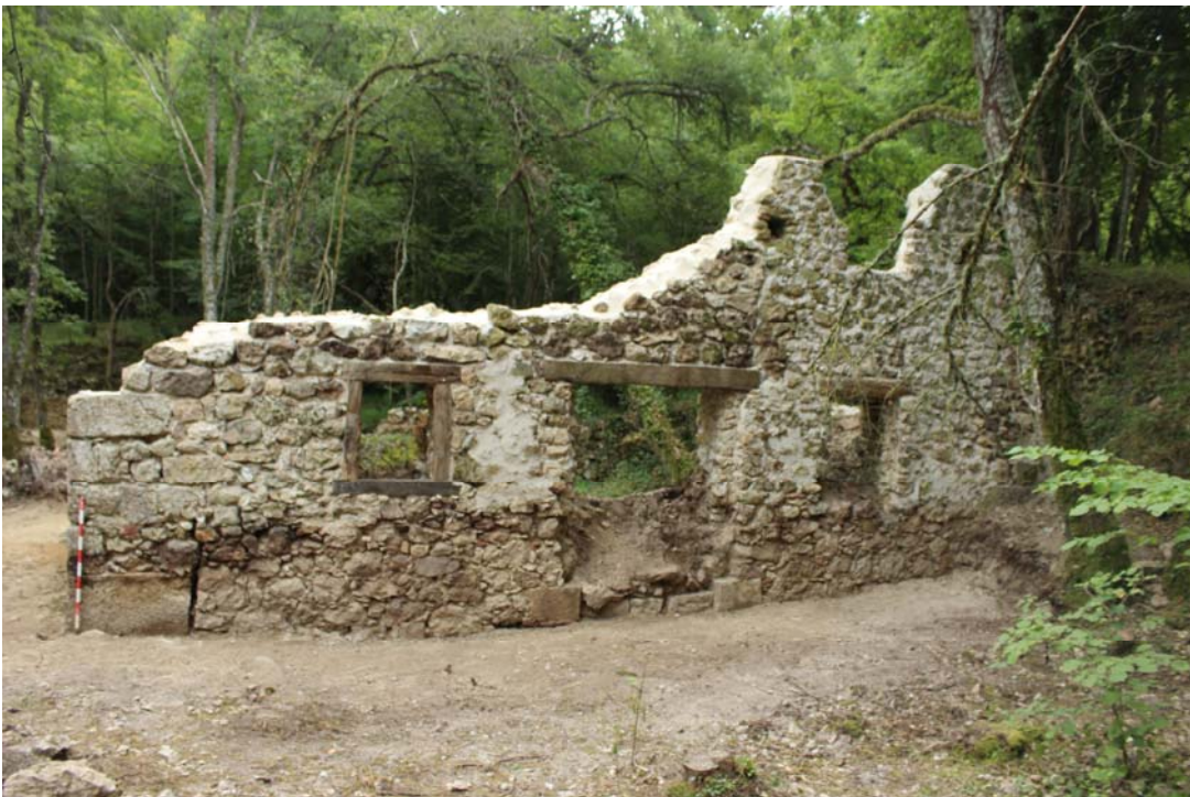
Foto 6. Vista después de la intervención.
