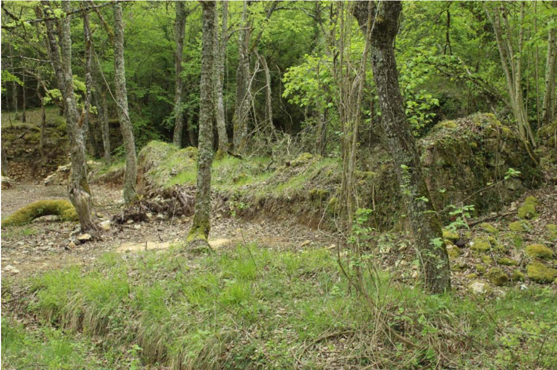
Foto 8. Vista inicial del muro E.
