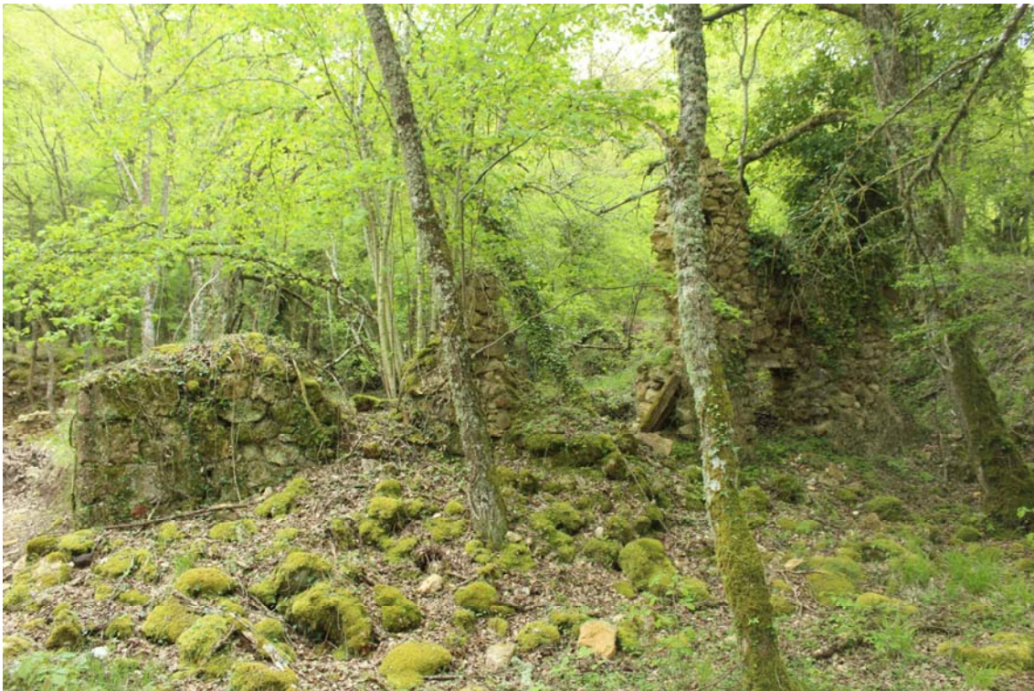
Foto 1. Estado inicial antes de la intervención de restauración por parte de la empresa de albañilería.
