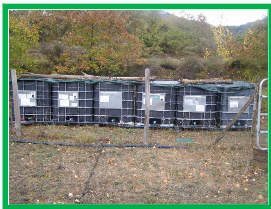
Imagen de los 6 depósitos de 1.000 litros pintados de negro
